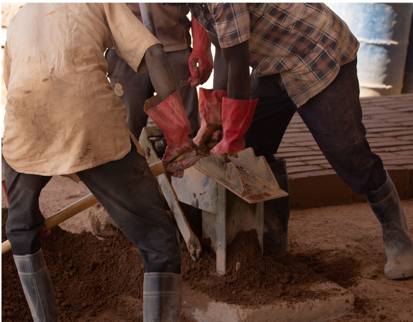
Fabrication des briques en terre compressée (BTC)
