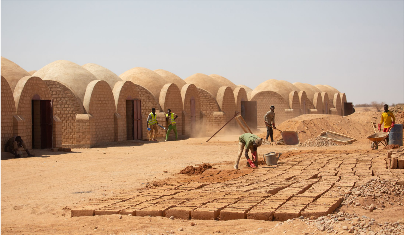
Construction de logements sociaux
