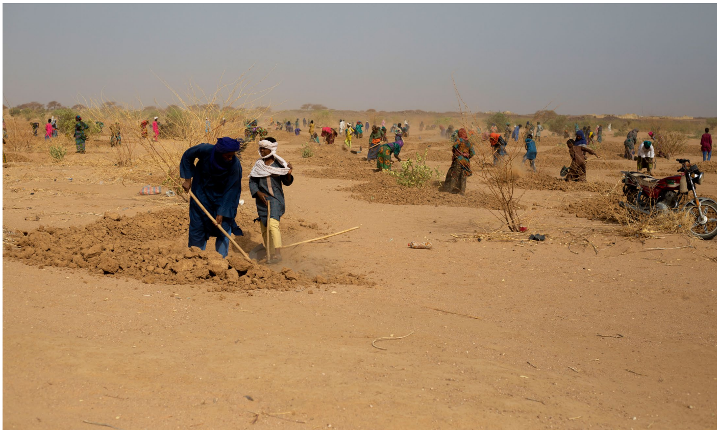
Travaux des demi lunes, localité de Tchirozerine / Agadez
