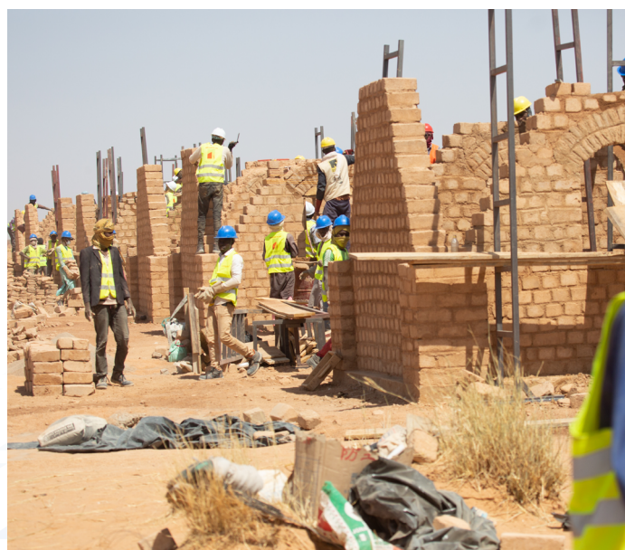
Chantier de construction de logements sociaux à Agadez
