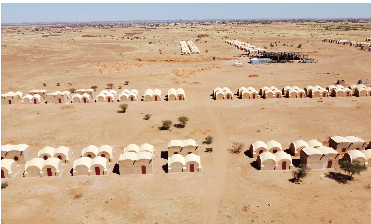
Vue aérienne du chantier des logements sociaux réalisés par l'ONG CISP dans la région d'Agadez
