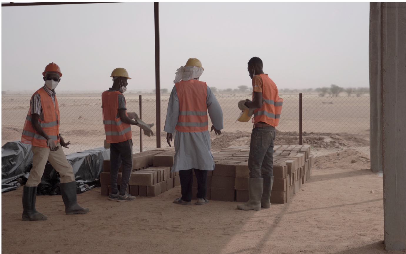
Fabrication de briques en terre stabilisée pour la construction de Logements sociaux à Agadez
