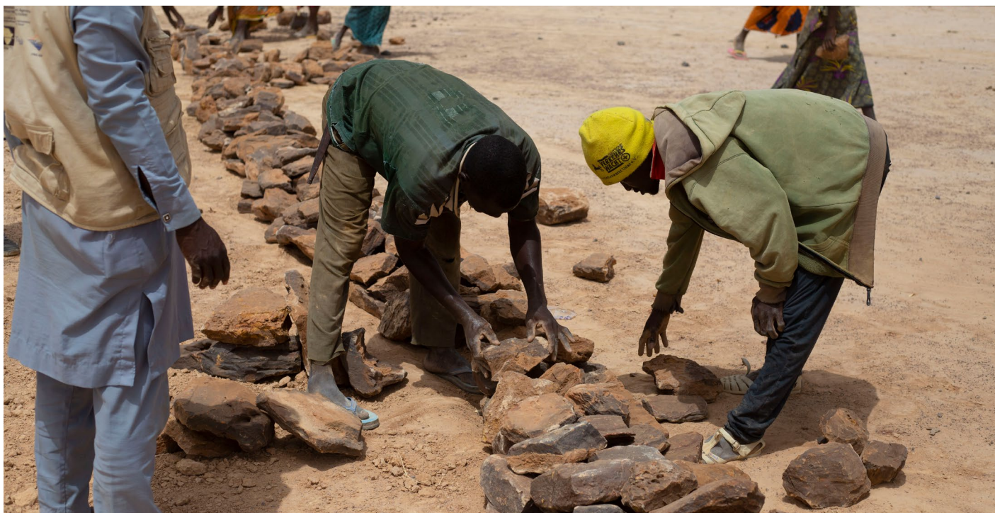
Fabrication des ouvrages antérosifs, commune de Bagarou
