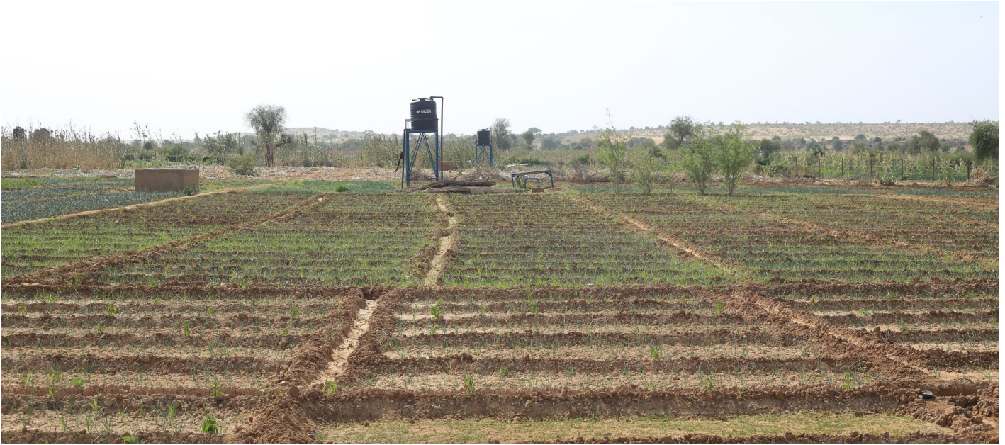
Forages et système de distribution d'eau pour l'horticulture dans une plantation
