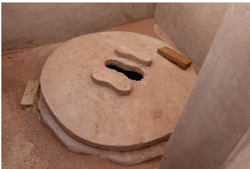
Dans le cadre du projet, le CISP avait initialement prévu la construction des murs des latrines en poêles de matériel végétal. Afin de garantir une supérieure durabilité des infrastructures - surtout face à la croissante instabilité climatique - le choix a viré sur une technique mixte prévoyant l'utilisation de matériaux définitifs pour le crépissage et de terre crue ou stabilisée pour les briques.
