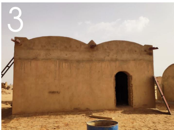
Le CISP a prévu trois différentes typologies de construction : le premier (image 1), en utilisant briques en terre stabilisée / comprimée - coupole ; un deuxième (2), avec briques en banco (terre comprimée avec pourcentage de ciment négligeable) ; enfin, un troisième (3) en voute, aussi en banco.
